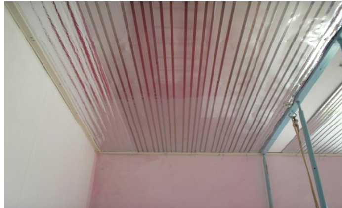
Рис. 8. Общий вид закрепленных электронагревателей
