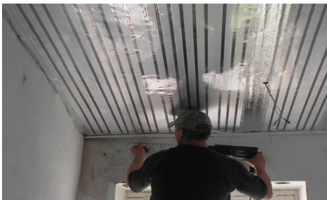
Рис. 9. Процесс крепления нагревателя
